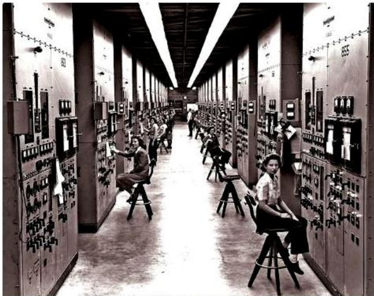
Des opératrices de calutron, à l'usine Y-12 de Oak Ridge, pendant la Seconde Guerre mondiale. Les calutrons servaient à raffiner le minéral d'uranium.
